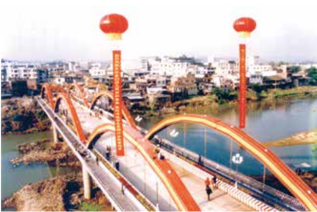
▲ 2001年11月，新建的河口大桥竣工通车
