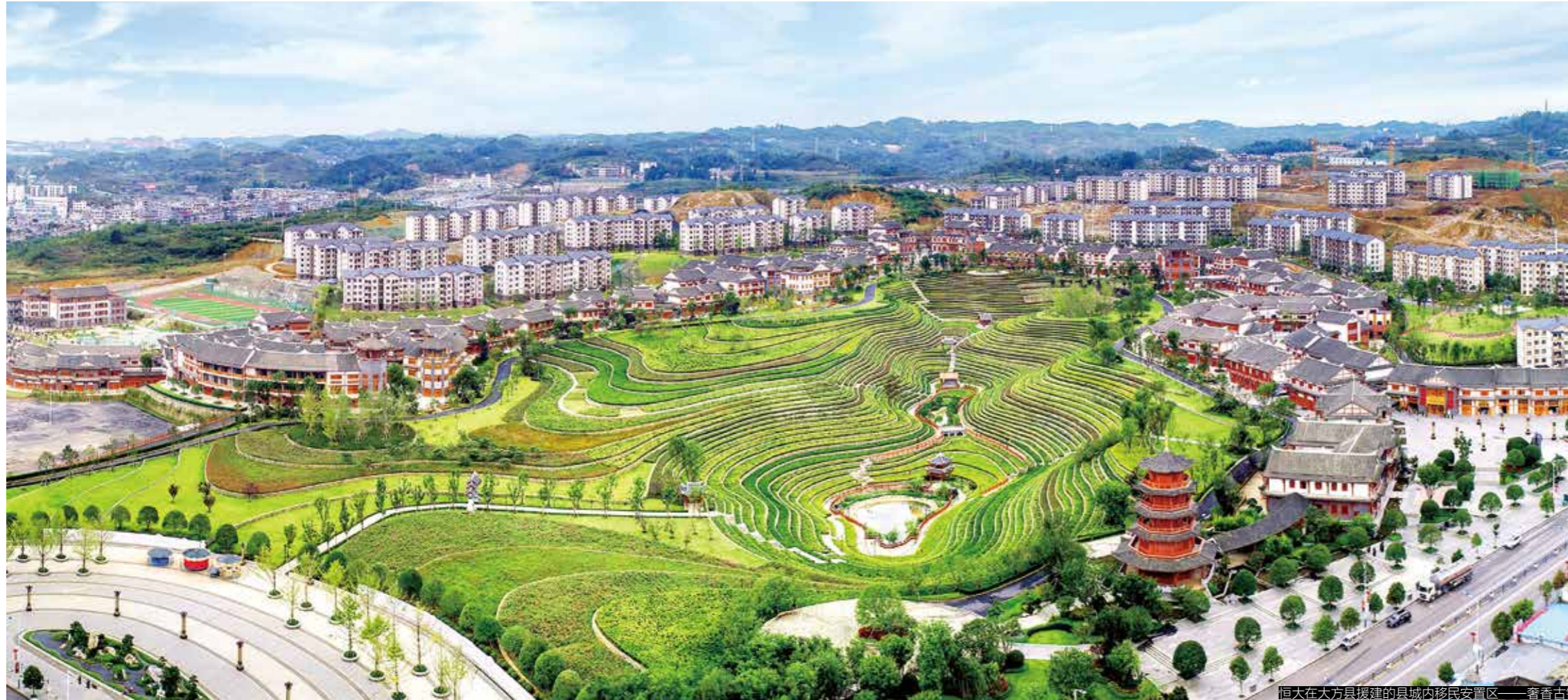
恒大大方县援建的县城内移民安置区——奢香古镇
